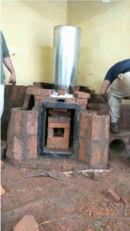
Imagen 6: Torreta en altura final y contenedor de aislación en posición
