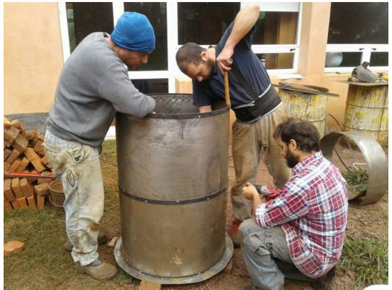
Imagen 9: Construcción de módulos de piel exterior
