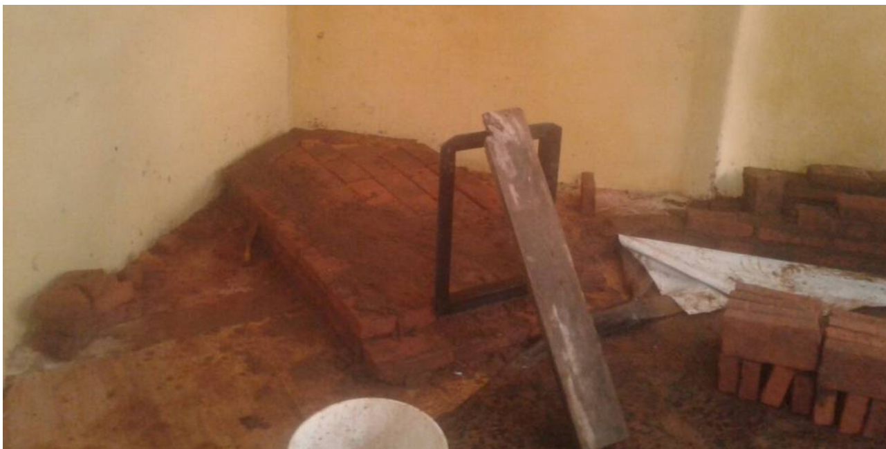
Imagen 4: Base aisladora y marco de puerta en posición
