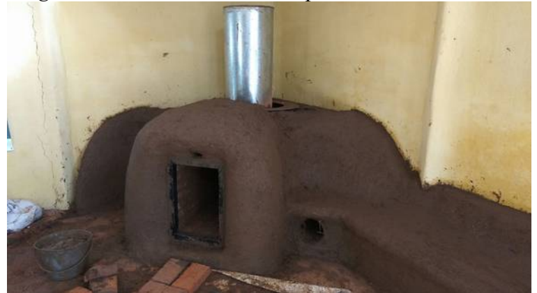
Imagen 8: revoque grueso en camino
